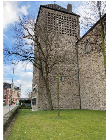
Station Lebenslust: Turm der Kreuzkirche
